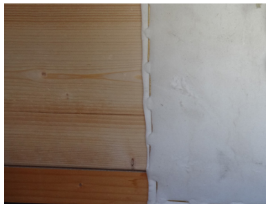
Zabezpieczenie łącznika - płytki kolczastej okładziną ognioodporną
