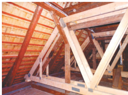
Fot. 1. Układ dwuwieszarowy w kościele św. Zofii w Bobowej wzmocniony więzarami
