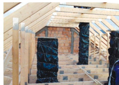
Fot. 3. Dach z wiązarów z poddaszem użytkowym
