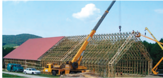
Fot. 2. Montaż wiązarów o dużej rozpiętości za pomocą dwóch dźwigów
