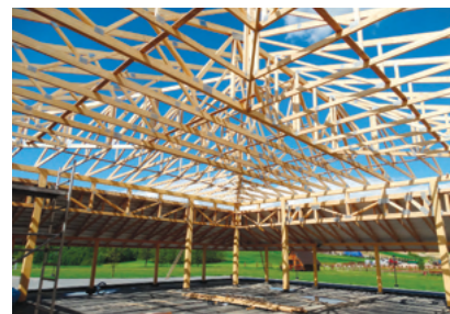
Fot. 2. Konstrukcja dachu o rozpiętości 26 m
